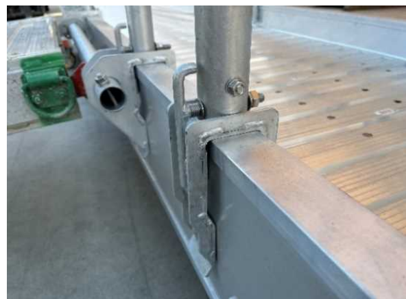
可動手摺幅木部への取付
